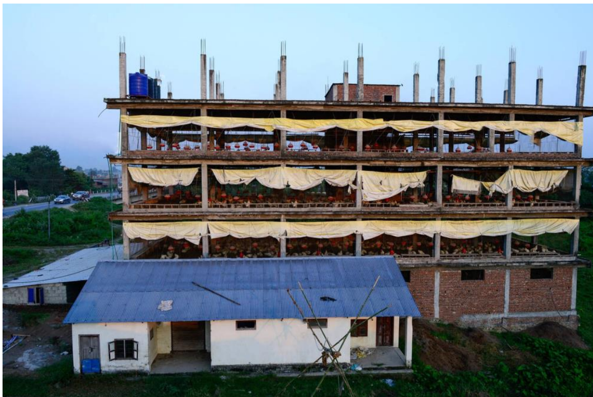
Fot. 3. Adaptowany budynek po niedokończonym supermarkecie wykorzystywany do chowu drobiu w Nepalu
